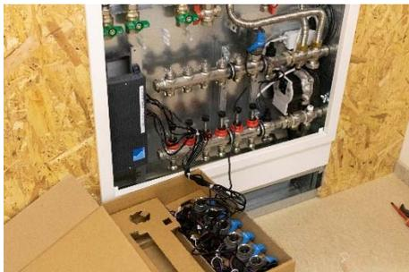
5 EGOs der Nummerierung nach montieren (zur einfachen Montage sollten die Fühlerkabel vor dem Verteiler verlaufen)
